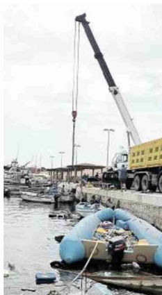
La rimozione dei barchini
